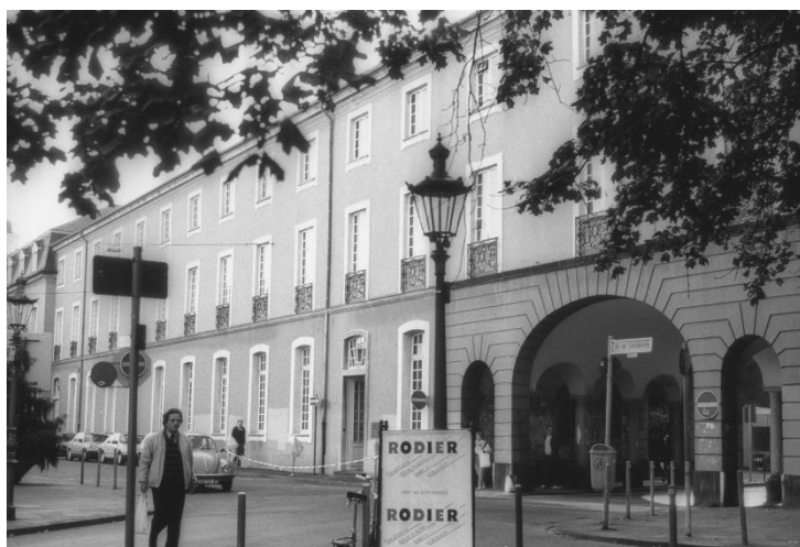
Abbildung 7: Seitenflügel des Hauptgebäudes in der Franziskanerstraße 2, 1951-1987
