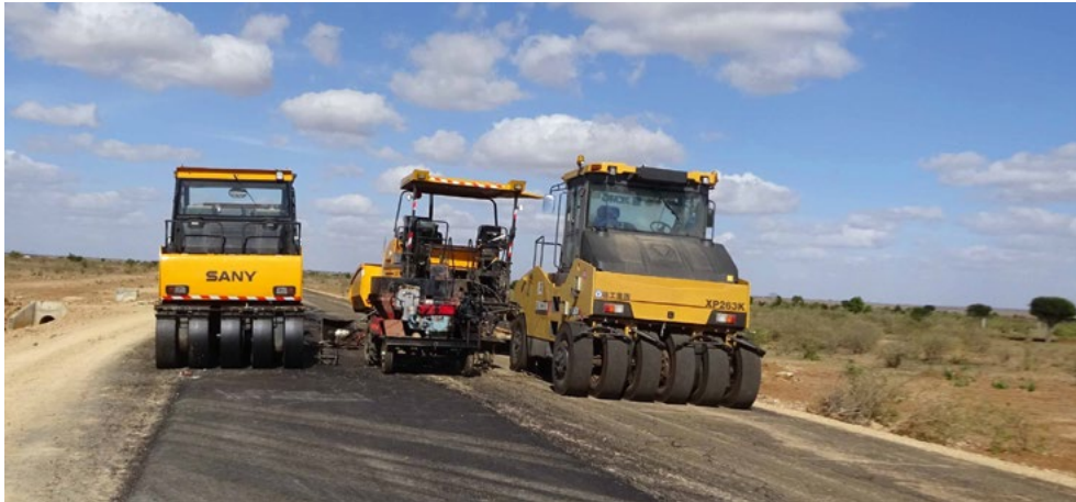
Im Bau befindliche Straße
