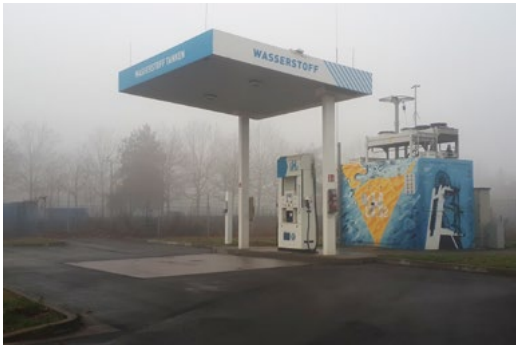
Wasserstofftankstelle in Herten
